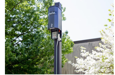
Pole Mount EVSE
